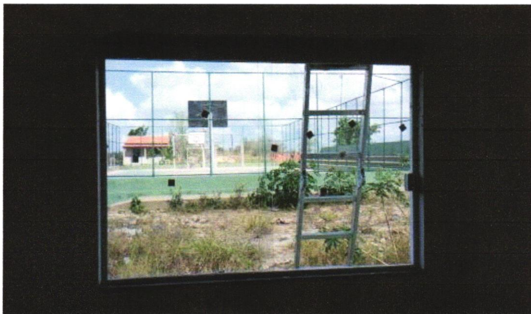
FOTO 31 -JANELA DE ALUMÍNIO DE CORRER COM 2 FOLHAS PARA VIDROS, COM VIDROS, BATENTE, ACABAMENTO COM ACETATO OU BRILHANTE E FERRAGENS. EXCLUSIVE ALIZAR E CONTRAMARCO. FORNECIMENTO E INSTALAÇÃO. AF_12/2019
