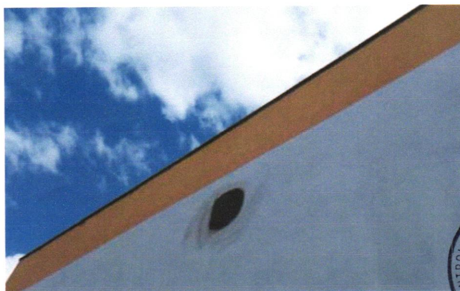
FOTO 02 – Chapim de concreto pré-moldado
