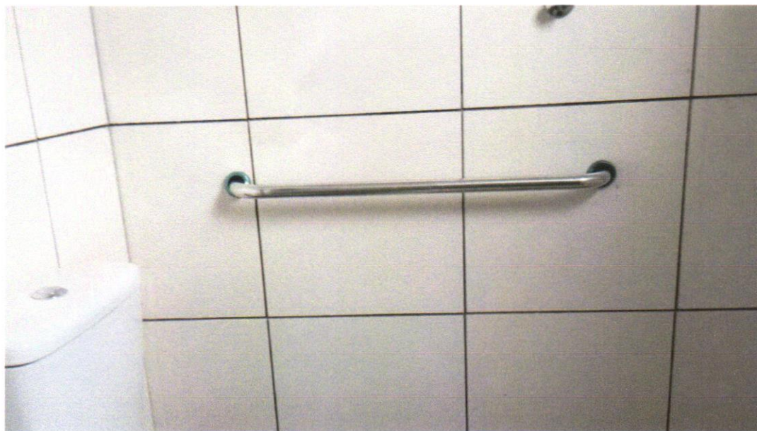
FOTO 39 - BARRA DE APOIO RETA, EM ALUMINIO, COMPRIMENTO 60 CM, FIXADA NA PAREDE - FORNECIMENTO E INSTALAÇÃO. AF_01/2020
