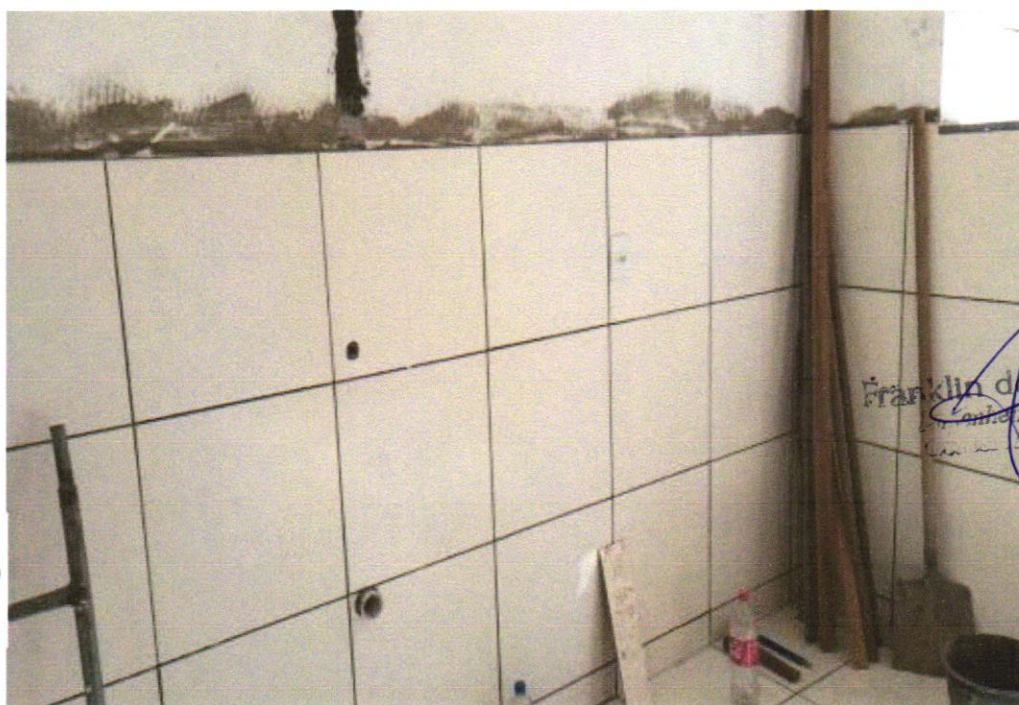
FOTO 21 - REVESTIMENTO CERÂMICO PARA PAREDES INTERNAS COM PLACAS TIPO ESMALTADA EXTRA DE DIMENSÕES 33X45 CM APLICADAS EM AMBIENTES DE ÁREA MAIOR QUE 5 M 2 A MEIA ALTURA DAS PAREDES. AF_06/2014
