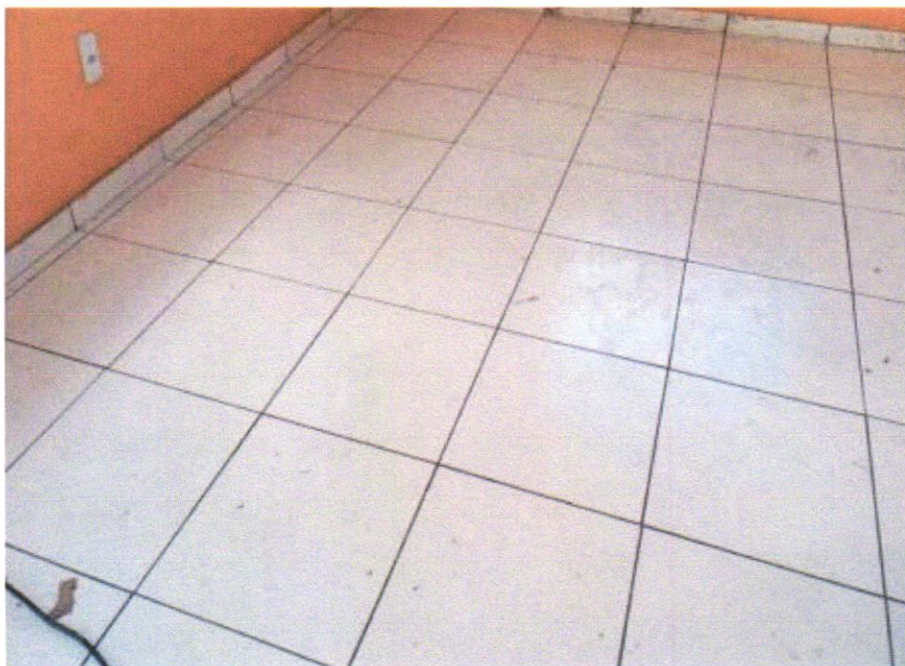
FOTO 19 - REVESTIMENTO CERÂMICO PARA PISO COM PLACAS TIPO ESMALTADA EXTRA DE DIMENSÕES 45X45 CM APLICADA EM AMBIENTES DE ÁREA ENTRE 5 M2 E 10 M2. AF_06/2014
