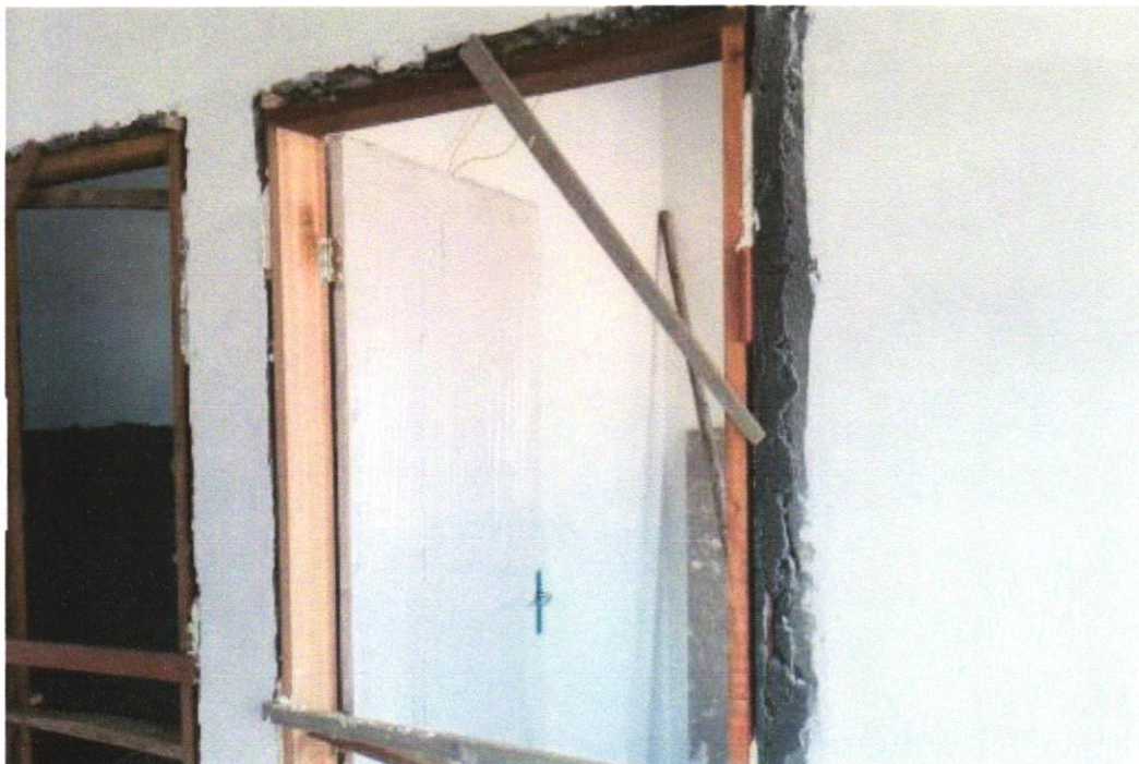
FOTO 25 -KIT DE PORTA-PRONTA DE MADEIRA EM ACABAMENTO MELAMÍNICO BRANCO, FOLHA LEVE OU MÉDIA, 90X210CM, EXCLUSIVE FECHADURA, FIXAÇÃO COM PREENCHIMENTO PARCIAL DE ESPUMA EXPANSIVA - FORNECIMENTO E INSTALAÇÃO. AF_12/2019
