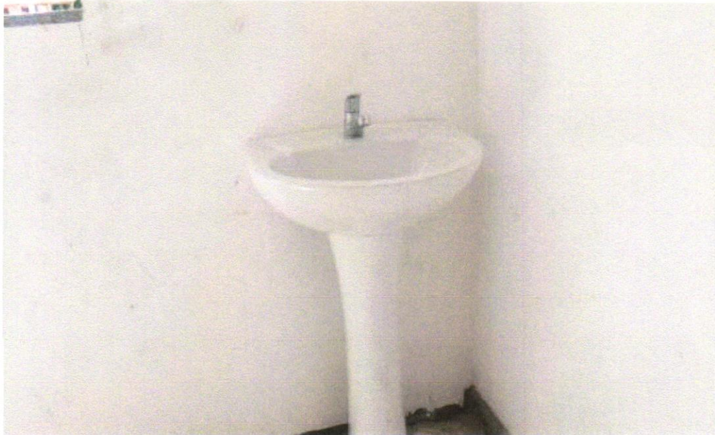
FOTO 17 - LAVATÓRIO LOUÇA BRANCA COM COLUNA, *44 X 35,5* CM, PADRÃO POPULAR, INCLUSO SIFÃO FLEXÍVEL EM PVC, VÁLVULA E ENGATE FLEXÍVEL 30CM EM PLÁSTICO E COM TORNEIRA CROMADA PADRÃO POPULAR - FORNECIMENTO E INSTALAÇÃO. AF_01/2020
