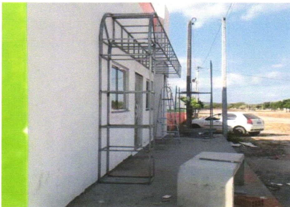
FOTO 37 - Revestimento metálico em alumínio composto (Alucobond), e=0,3mm, pintura Kaynar 500 composta por seis camadas, inclusive estrutura metálica auxiliar em perfil de viga "U" de 2" - fornecimento e montagem
