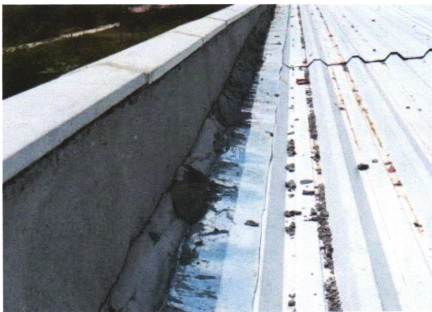
FOTO 03 - Rufo em chapa aço galvanizado nº24 com desenvolvimento 25cm
