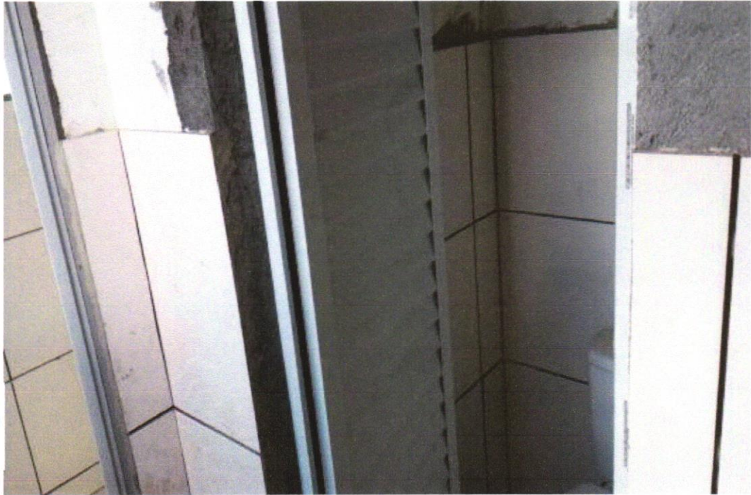
FOTO 27 - PORTA EM ALUMÍNIO DE ABRIR TIPO VENEZIANA COM GUARNIÇÃO, FIXAÇÃO COM PARAFUSOS - FORNECIMENTO E INSTALAÇÃO. AF_12/2019
